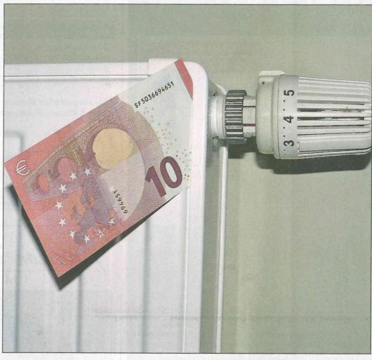
und Heizkosten. Weit verbreitet ist die Vorstellung vom Ventil als Wasserhahn: Je stärker aufgedreht, umso schneller steigt die Raumtemperatur. Das ist nicht der Fall. Statt schneller, heizt man auf diese Weise einfach nur länger.
